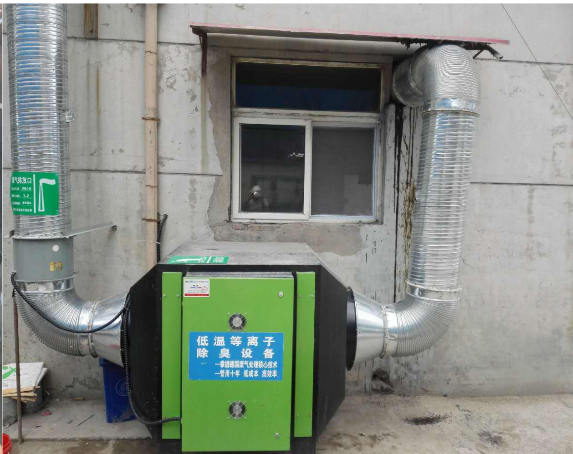
油烟净化器及废气排放筒 P7
