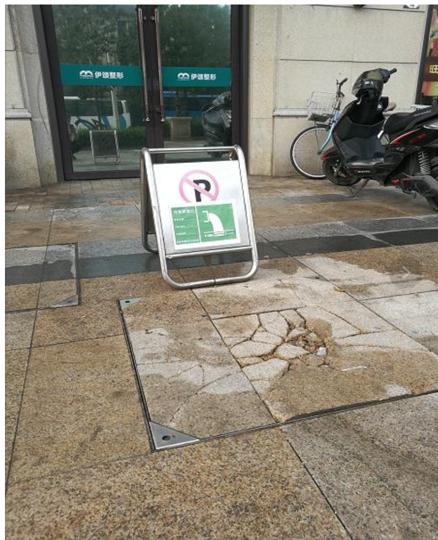
生活污水排放口
