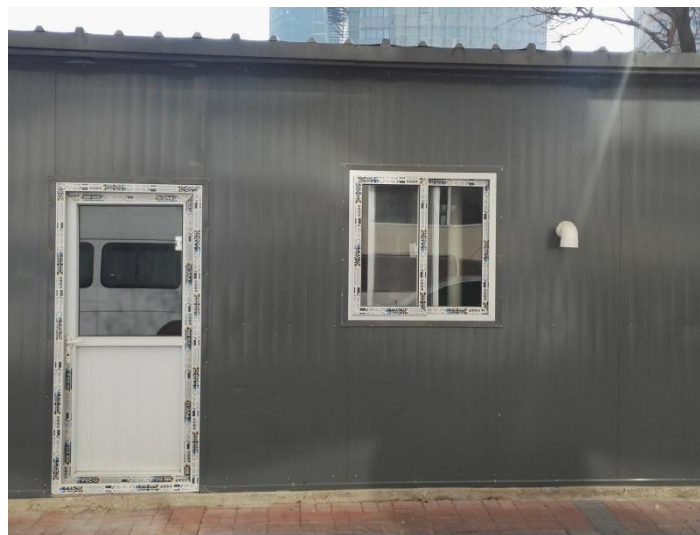
污水处理站外部
