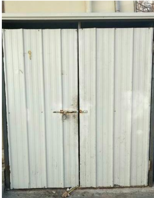
一般固废暂存处外部
