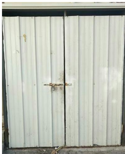
一般固废暂存处外部
