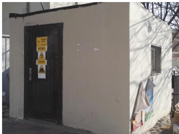
医疗废物暂存处外部
