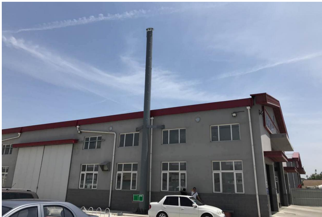
1#车间废气排气筒 P1 及标识牌
