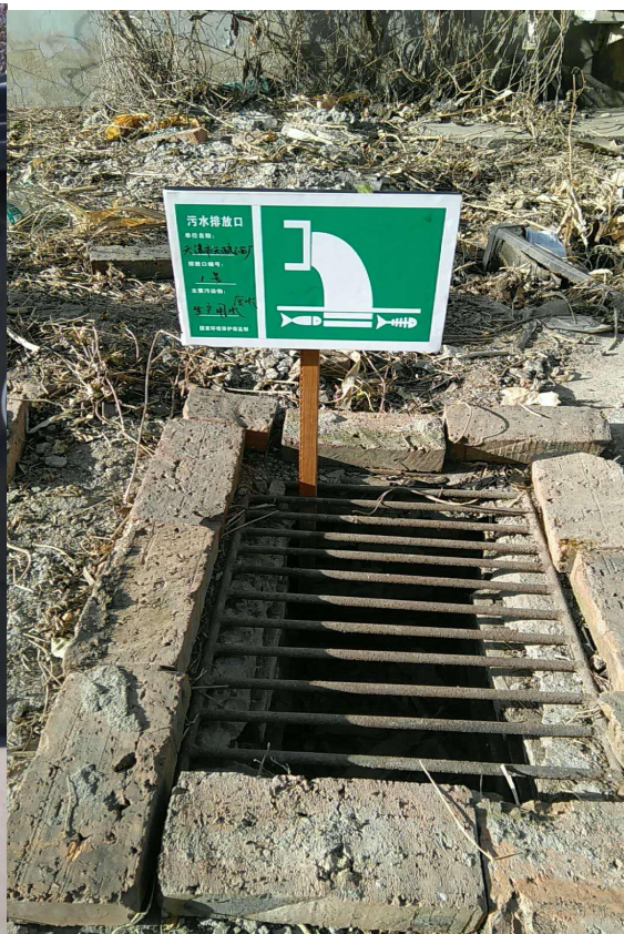
废水总排放口
