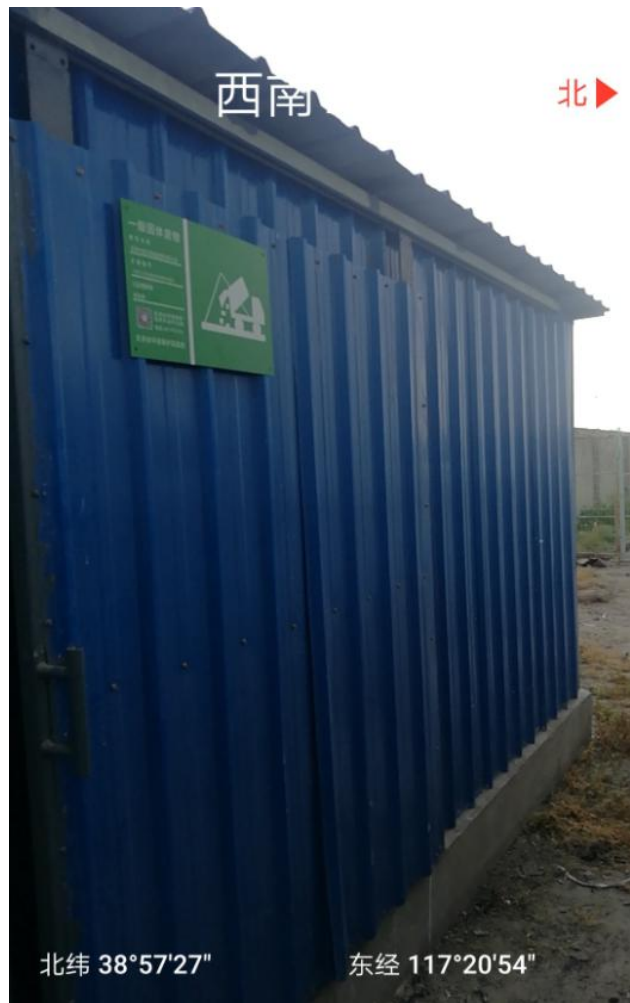
一般固体废物暂存处
