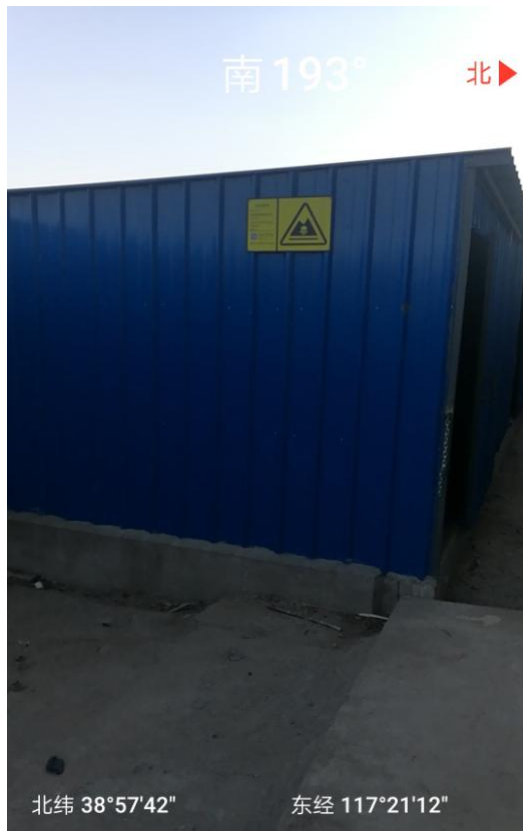
危险废物暂存处
