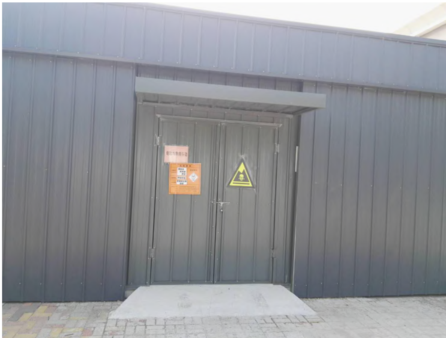
图 5.14 危险废物暂存间规范化
