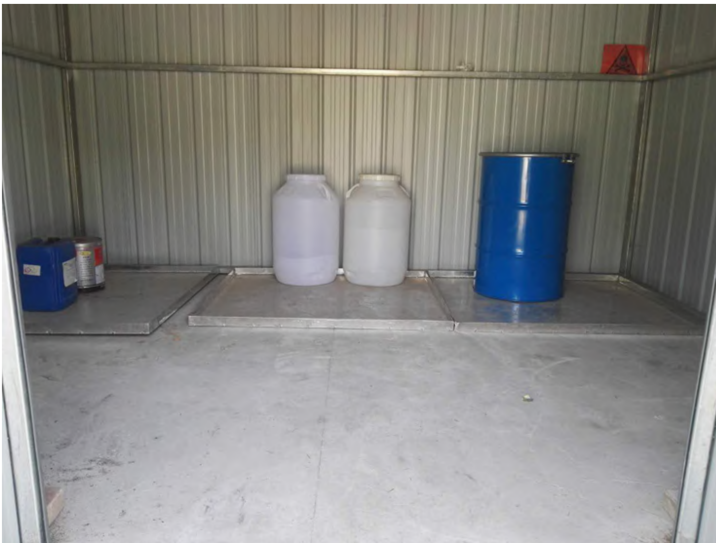
附图 7.2 危废暂存间防渗托盘
