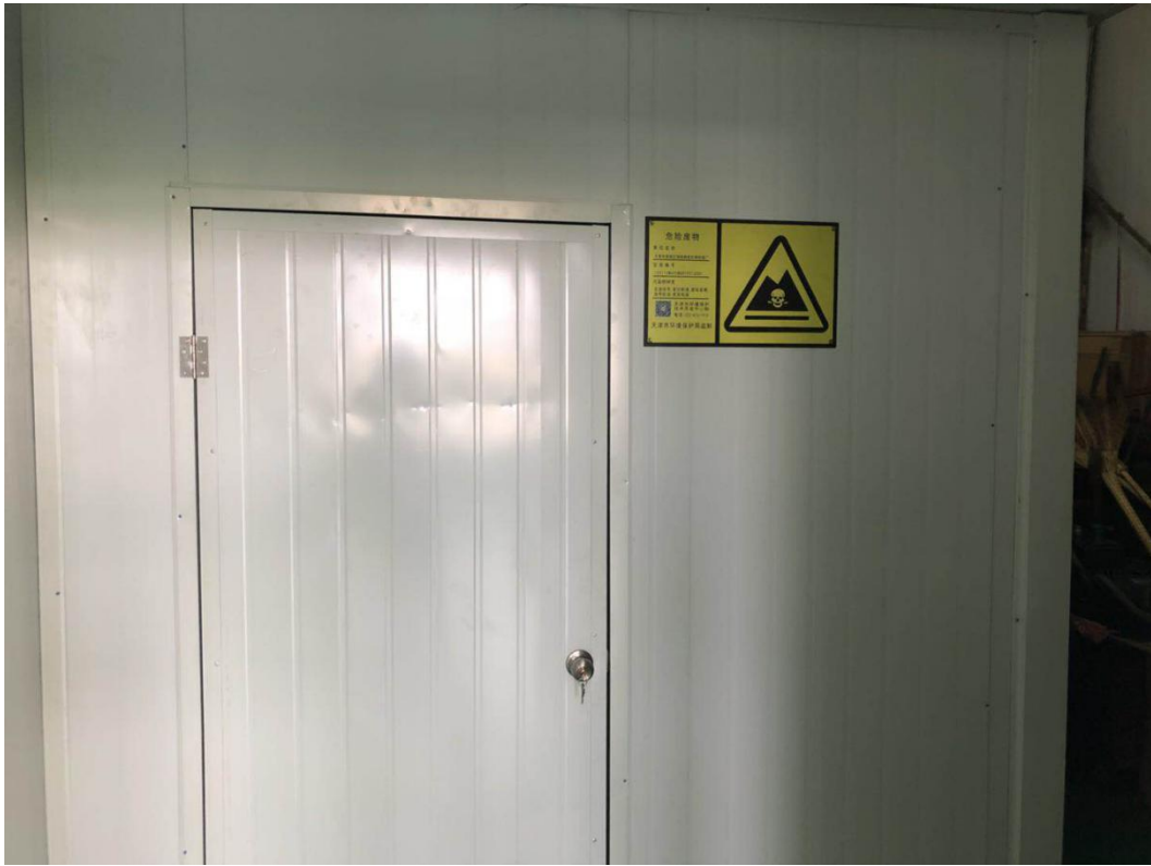
危险废物暂存处
