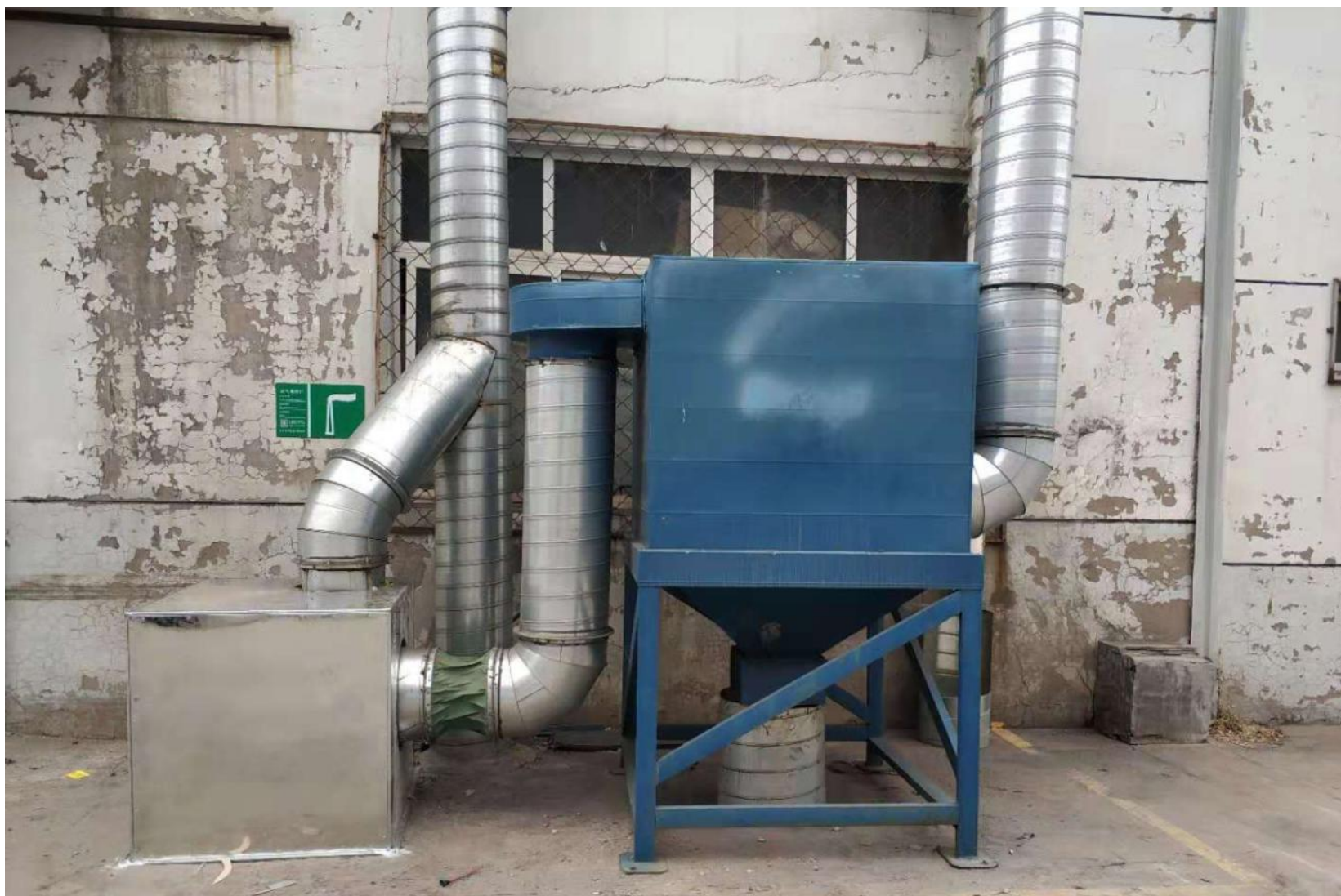
附图 6 滤筒除尘器
