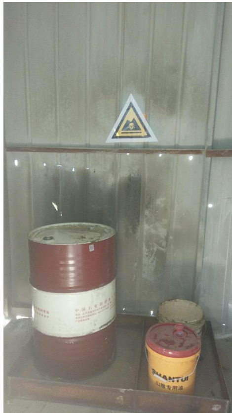
危废暂存间及标识牌
