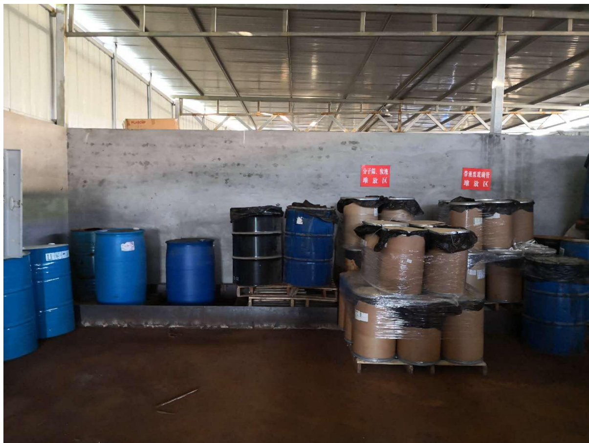
危废暂存间防渗托盘
