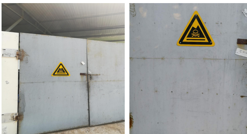
危废暂存间原貌
