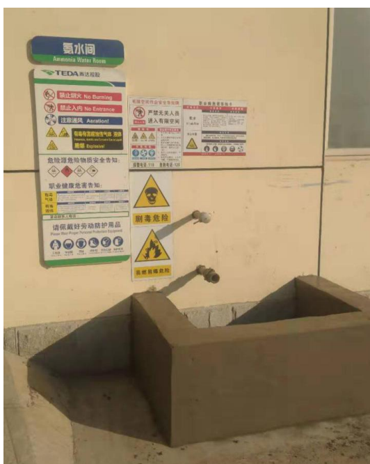
氨水间应急收集池
