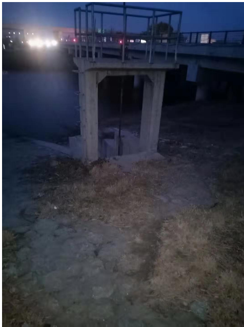
雨水外排闸门
