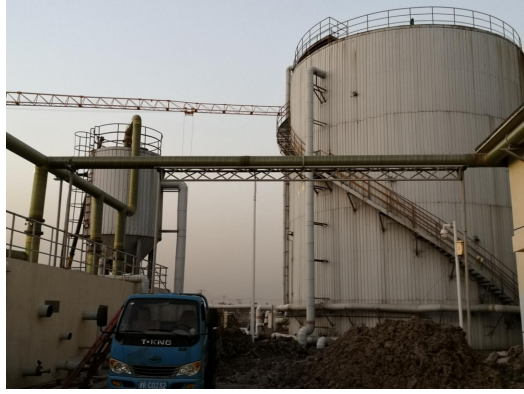
渗滤液处理站废气送至焚烧炉管道
