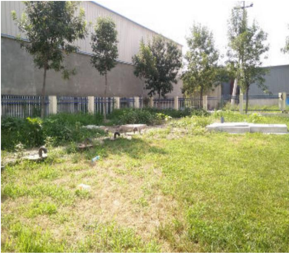
地埋式生活污水处理系统
