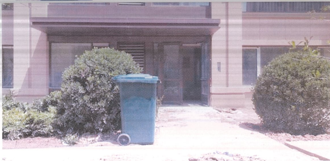
生活垃圾暂存处
