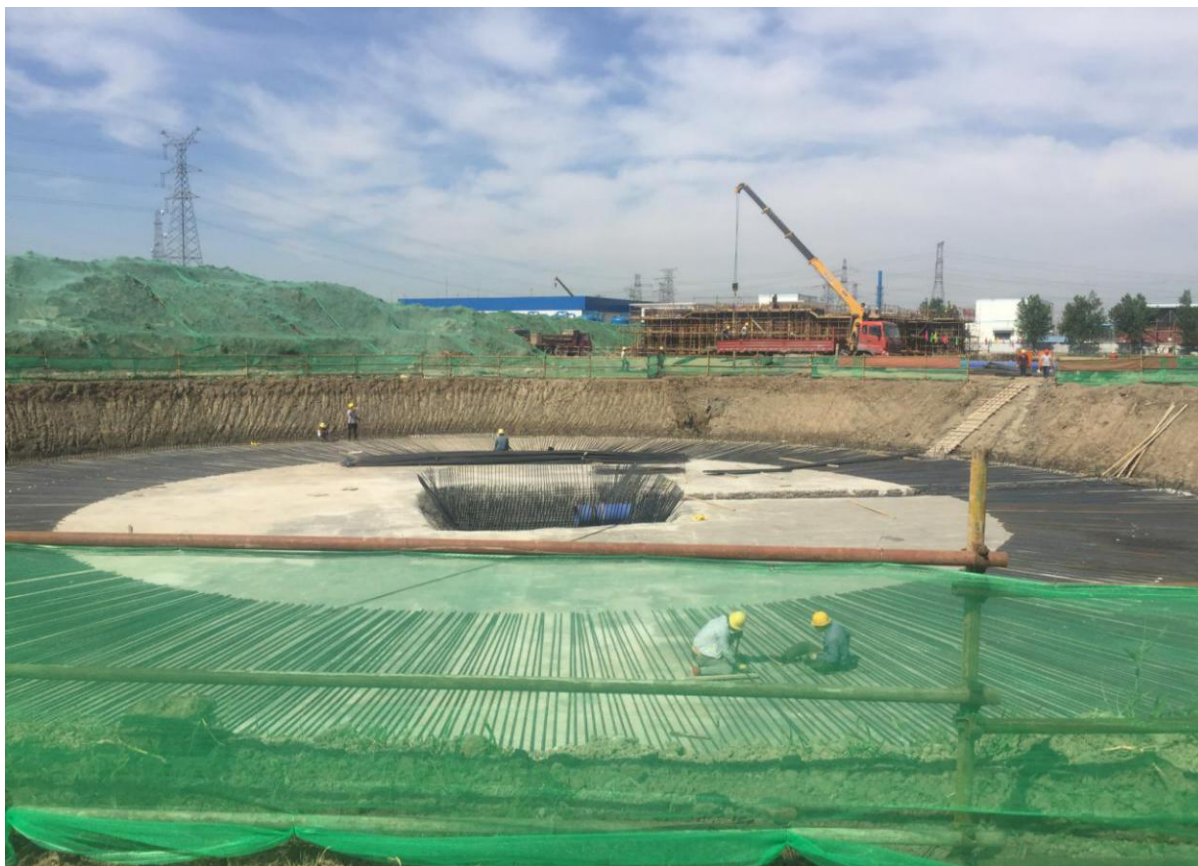
施工期环保措施
