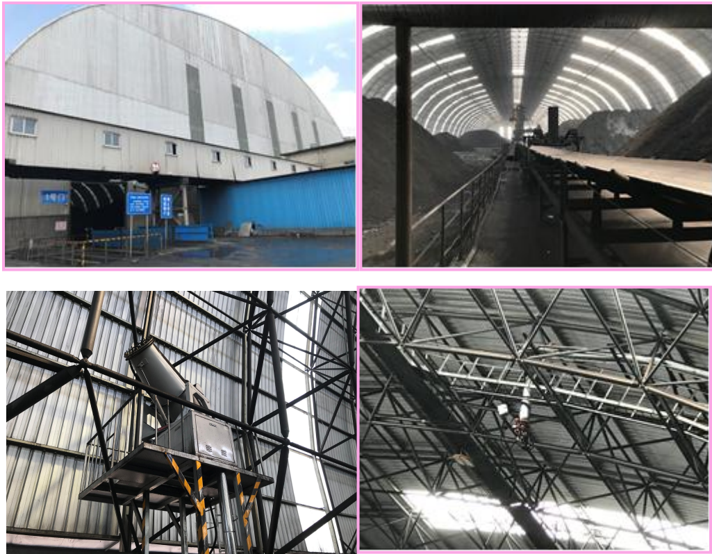
图 3.3-3 储煤场现场情况
