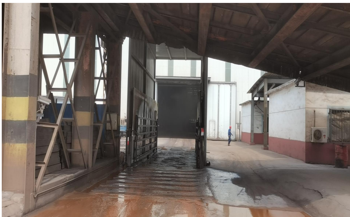
封闭区域出口汽车清洗设备
